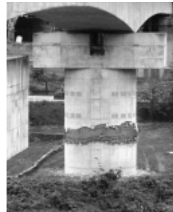
写真 - 1 橋脚段落し部被害状況
