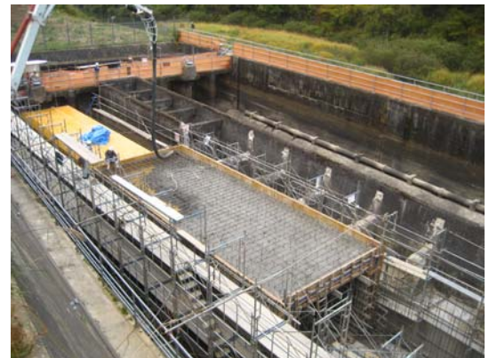
写真-1 F Aコンクリート打設状況 (ボックスカルバート)
