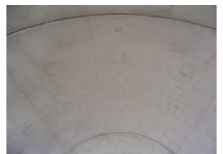
写真-4 脱枠後の外観(通常配合)
