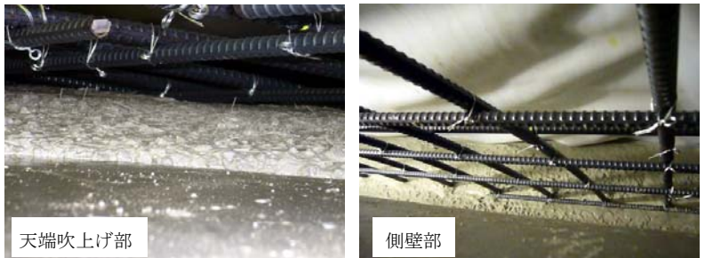
写真-3 コンクリートの流動状況(繊維配合)
