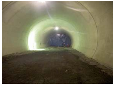
写真-2 コンクリート充てん状況・覆工仕上がり状況
