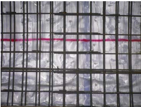
写真-1 二次覆工部配筋状況
