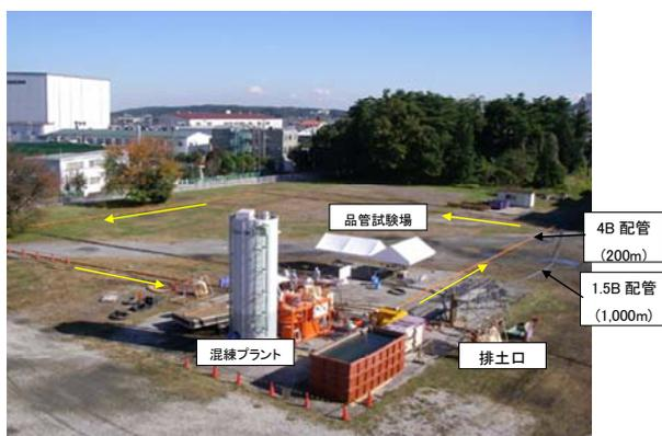
写真-1 ポンプ圧送実験状況
