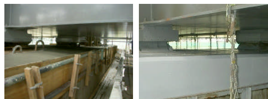
図-5 断面修復・表面保護工の状況
