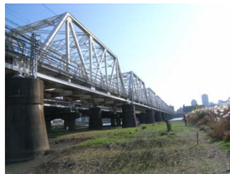
図－1 調査対象橋梁
