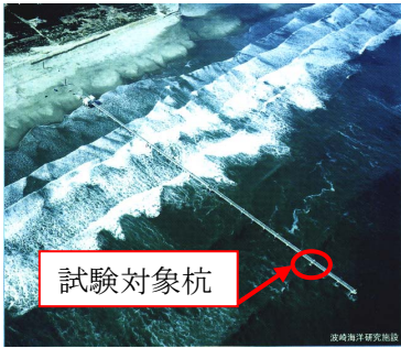
写真-1 観測栈橋と試験対象杭位置
