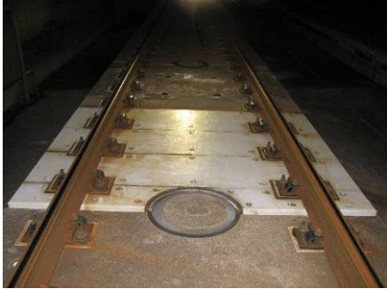
写真-2 施工 16 ヶ月後の状況
