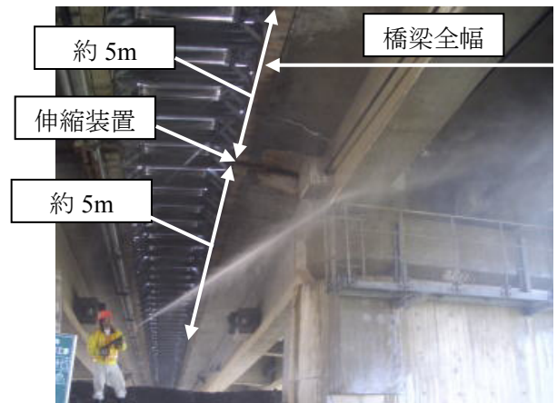
写真 1 洗浄の範囲、状況
