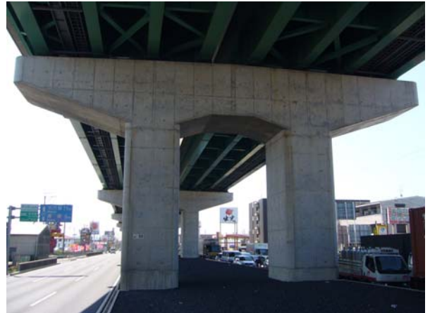
写真-1 計測橋脚
