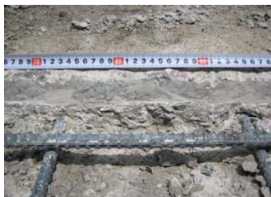
写真2 カッター切断面①(エリアA)
