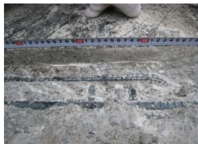
写真3 カッター切断面②(エリアB)
