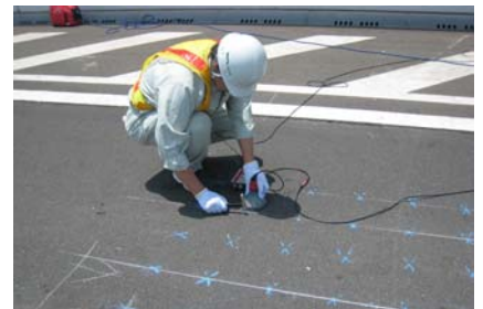
写真1 打音調査の実施状況
