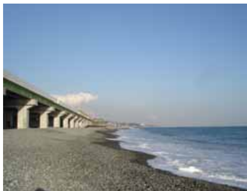
写真1 対象構造物の設置環境
