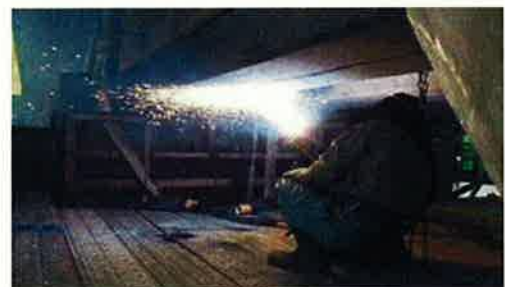
写真 1 下フランジへのチタン溶射の様子
