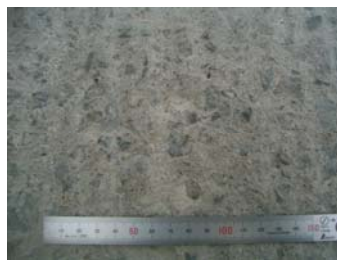
写真-5 床版面③
