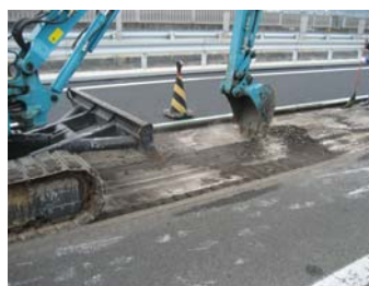
写真-1 アスコン除去状況
