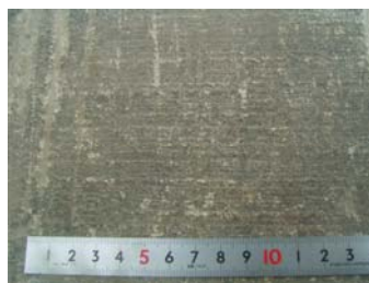
写真-3 床版面①
