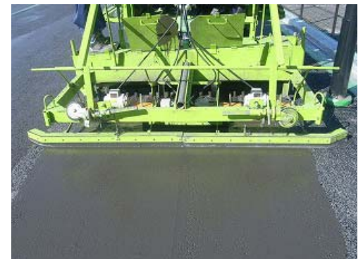
写真-2 保水材散布充填状況
