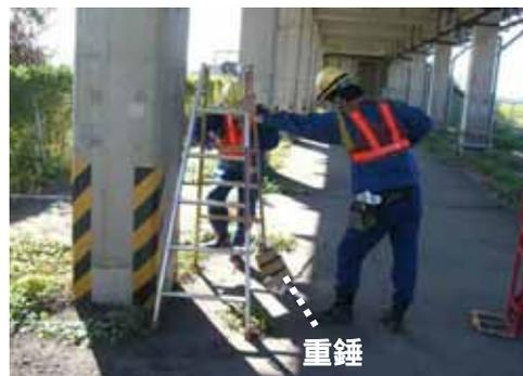
図-1 柱下部打撃手法の風景
