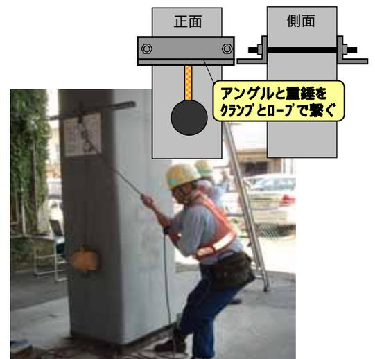
図-8 柱下部打撃の治具試作イメージ
