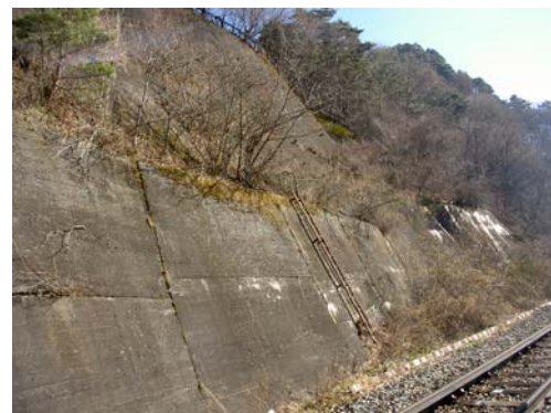
図1 張コンクリートの例
