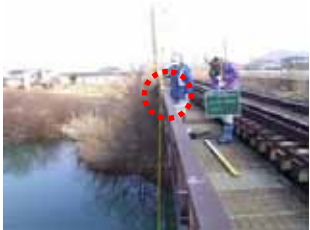
写真-11 測定状況
