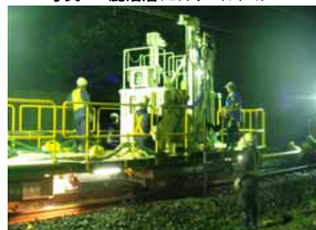
写真-3 注入施工状況
