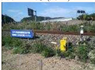
図-1 軌道盛土の計測事例
