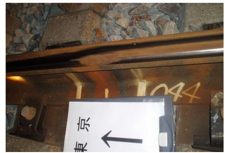
図-2 レール踏面の変化箇所
