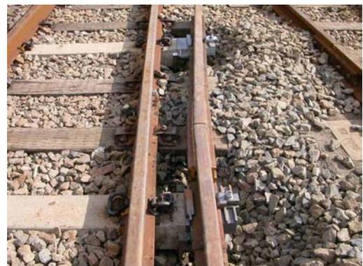
写真-7 端部安全レール設置状況
