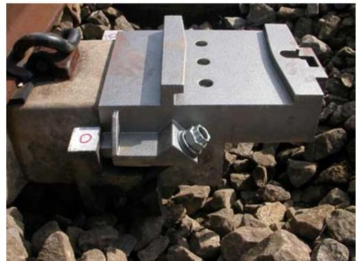
写真-6 端部用安全レール取付金具
