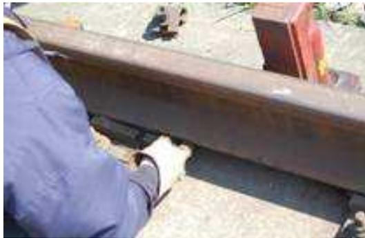
図-1 軌道パッド・可変パッド敷設
