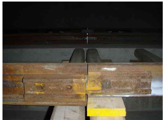
図-2 異形継目板
