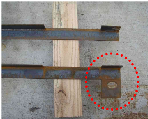
図-1 ゲージタイ(上：通常型・下：改良型)
