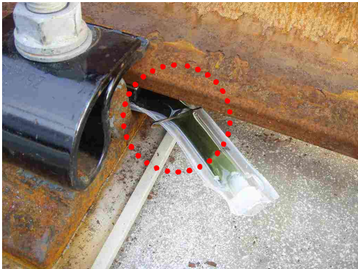
図-5 注入口・ヘアピン留め
