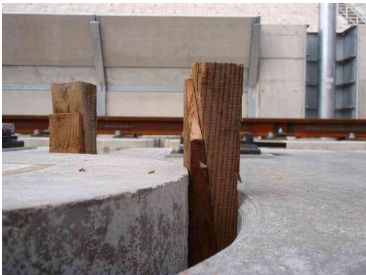
写真-3 クサビによるスラブ固定状況
