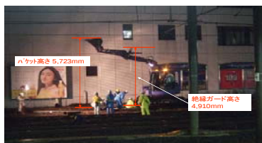
写真3 バックホウ試験風景（基地線にて実施）
