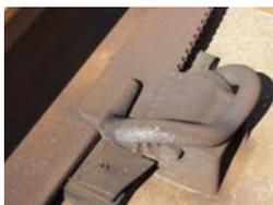
いては不良と判定する。 写真8 調整パッキンの破損状態
