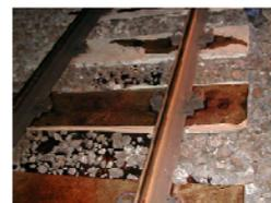
写真11 樹脂補修後の状態
