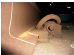
写真9 楔形インシュレーターの摩滅状態
