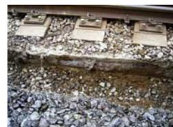
写真 3 路盤面からの出水状態
