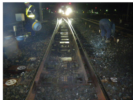
写真-1 85分岐器ロッド類撤去時の状態
