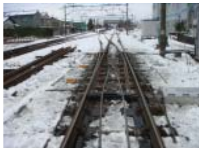
図6 試験敷設した寒冷地用次世代分岐器
