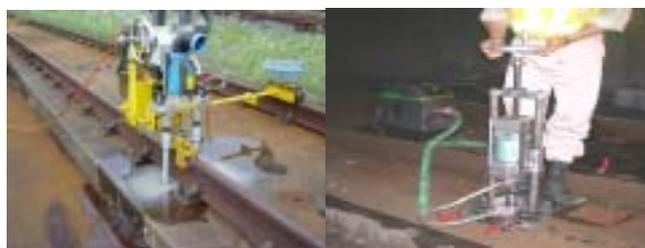
図2 まくらぎ穿孔機械(左)と開発したスラブ穿孔機械(右)
