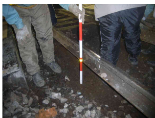
図-3 道床掘削目安確認風景
