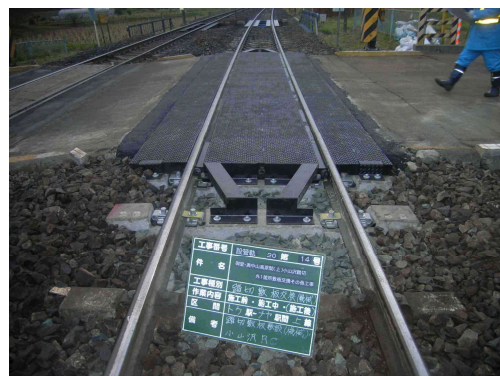
図-1 KG 式踏切道敷設施工後
