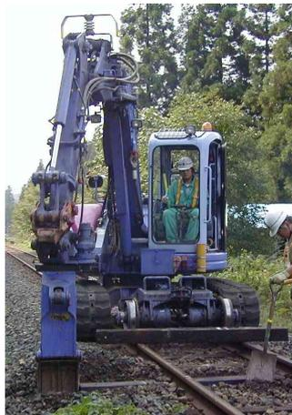
図-1 バックホウによるPCマクラギ交換
