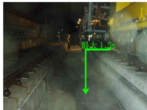
図-1 明り区間線路内状況
