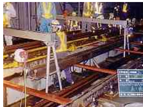
図-3 鋼材使用状況(明り区間)
