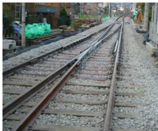
図-6 新分岐器敷設完了
