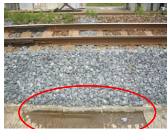
図3 ③における施工後の現場状況
