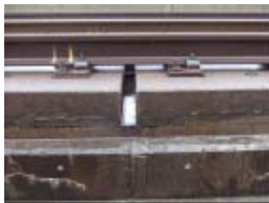
図4 スラブ下面の CA 補修
