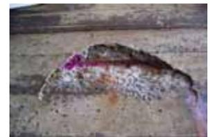
写真-4 コンクリート剥落状況
