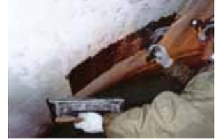
写真-6 接着材塗布状況
