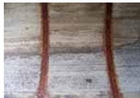
写真-3 H鋼の腐食状況
