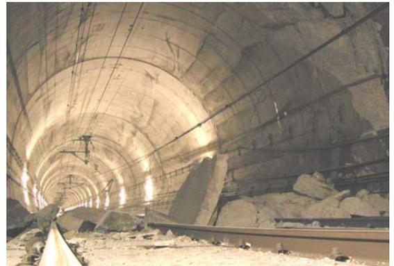
写真1 魚沼トンネルアーチ部崩落
