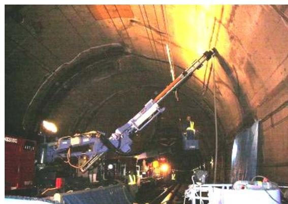
写真2 ロックボルト打設状況
