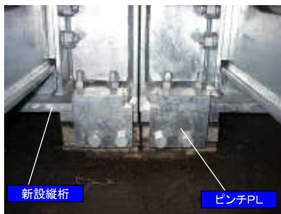
写真-2 支承部(架設後)
