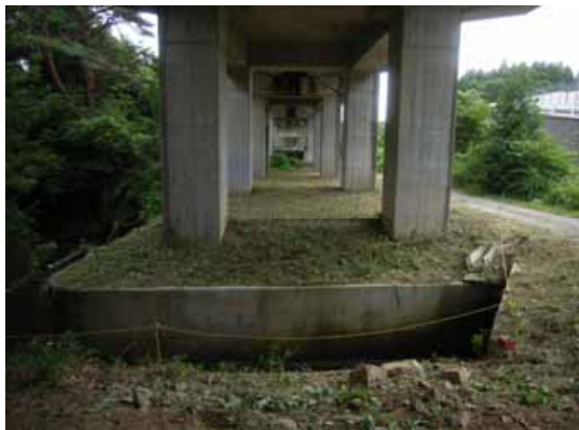
図-1. 沓座修繕工事の施工環境
