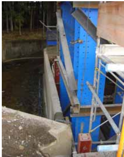
図-4. 仮受架台設置状況
