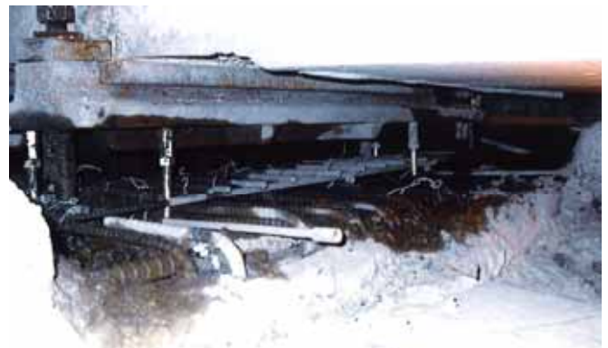
図-5. 沓座取壊し状況
