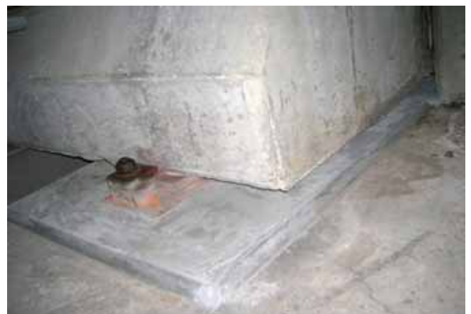
図-6. 施工後の沓座
