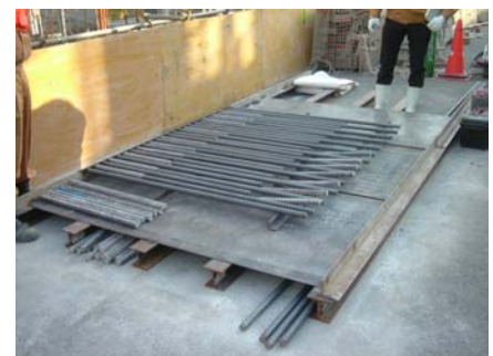
写真-1 試験体溶接作業架台
