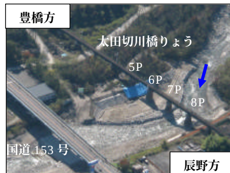
写真－1 太田切川橋りょうの全体写真
