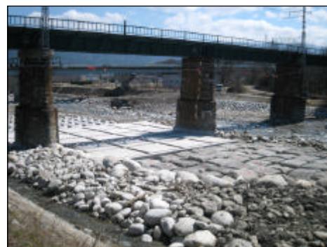
写真-3 復旧工事完了
