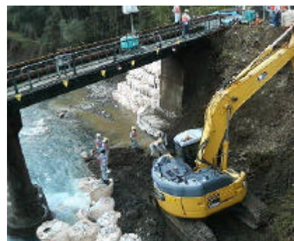
写真-2 仮締切工
