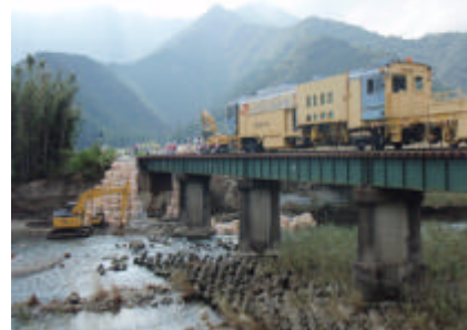
写真-3 載荷試験
