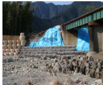
写真-4 応急工事完了
