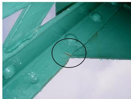
写真-2 斜材に発生した亀裂
