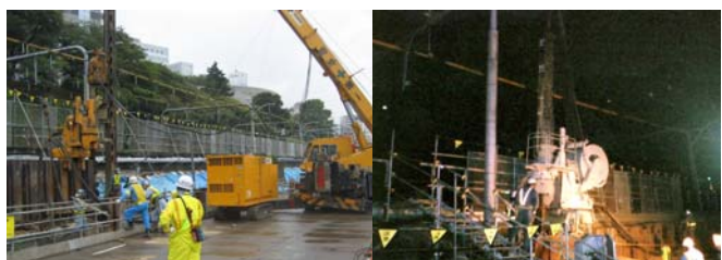
写真-4 オーガー併用圧入工法
