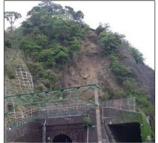
写真-1 崩壊時の状況
