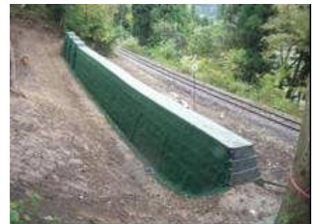
写真-2 飯山線 52k600m 補強盛土壁
