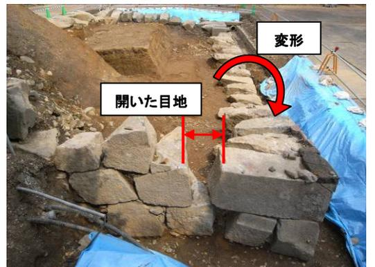
写真-3 根石変形状況
