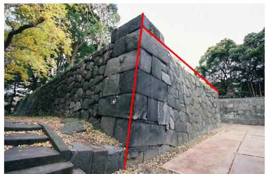
写真-2 石垣変形状況（修復前）
