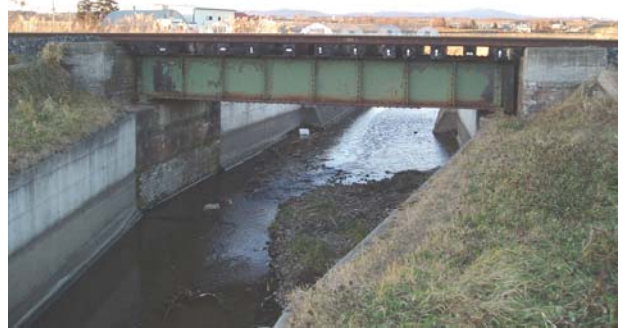
図-2 尻無川橋梁(研甲第529号)
