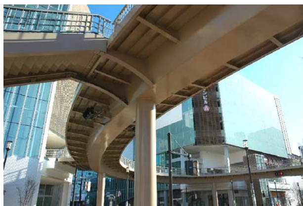
写真-5 デッキ裏面の様子(完成後)
